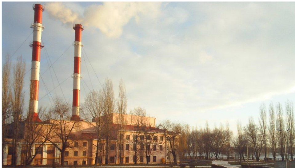
Рисунок 3 – котельная № 1 производственного подразделения Тепловые сети филиала
