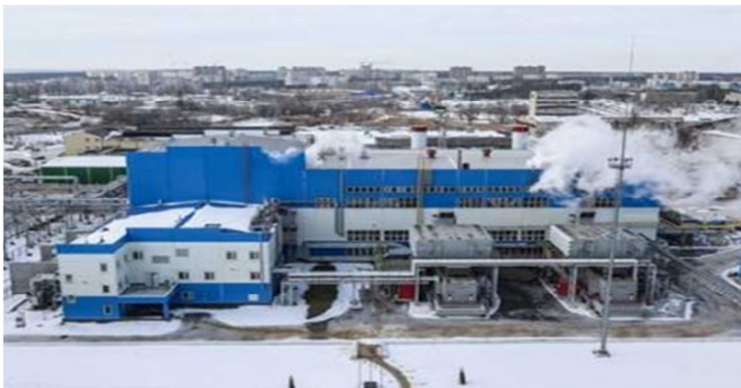
Рисунок 2 – Парогазовая установка мощностью 115 МВт (ПГУ-115 МВт) ПП ТЭЦ-2
